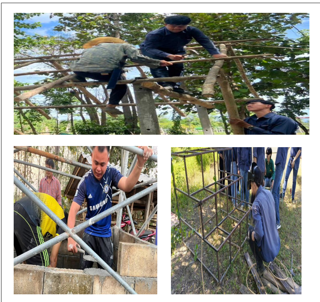
ภาพที่ 11 แสดงการสอนซ่อมสร้าง ปรับปรุง งานไม้ งานปูนและงานเชื่อมเหล็ก
